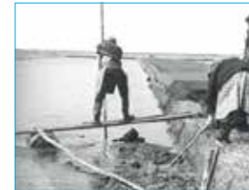
1 De veentrekker heeft een trekstok. Daarmee wordt het veen van de bodem losgetrokken en omhoog gehaald.
