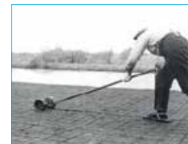
4 Als de brei wat droger is, wordt het in stukken gesneden met de 'stikrol', een mes dat vast zit tussen twee wielen.
